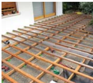
Structure sur cales sur sol dur
