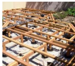
Structure sur plots sur sol stabilisé
